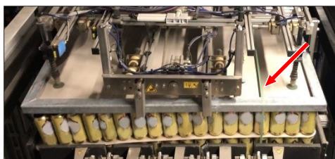
Abb. 57: Störung beim Deckrahmen abheben. Grund: Vergessenes, nicht abgenommenes umlaufendes Umreifungsband am Neubehälterstapel
